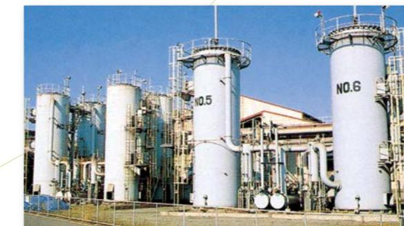
コークス炉ガス用乾式脱硫装置
