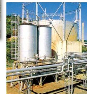
消化ガス用乾式脱硫装置
