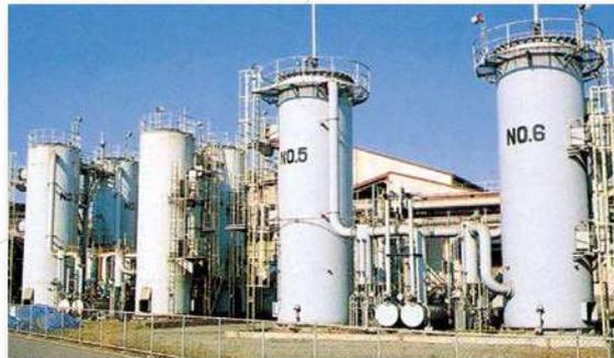
コークス炉ガス用乾式脱硫装置
