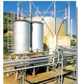
消化ガス用乾式脱硫装置
